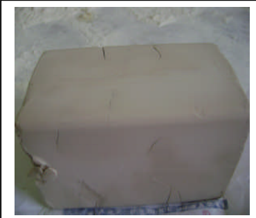
Resim1.10:Açım sırasında yüzey görünümü
