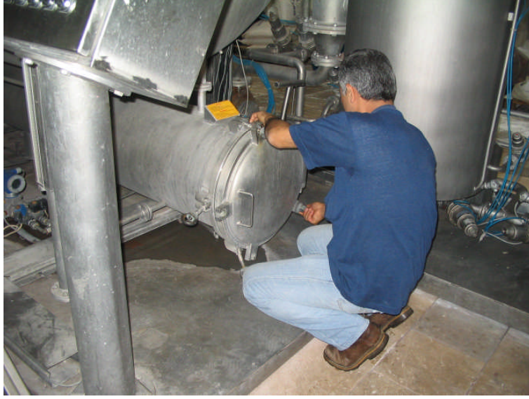
Resim 1. 7: Makine çalıştırılmadan önce filtre kontrol edilir.
