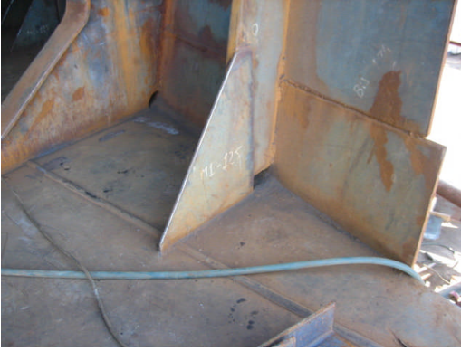
Resim 1.5: Posta braket bağlantısı
