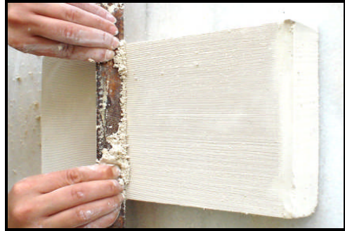
Resim4.12: Testere ile yüzeyi düzeltme
