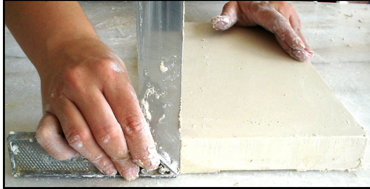
Resim.4.14:Alçı plakasının kenarlarının açı kontrolü
