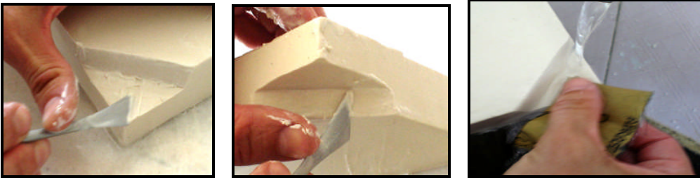
Resim5.7: Köşede üçgen pim açma aşamaları
