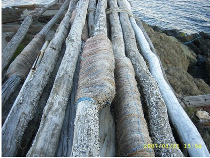
Resim 1.3: Dalyan kazıklarının eklem yerlerinin ağla sarılması
