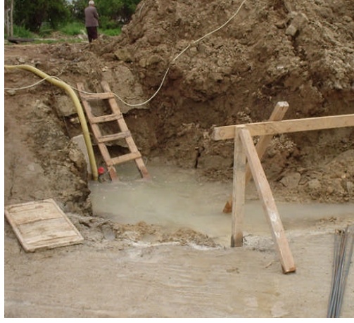
Şekil 14: Temel çukurundaki suyun boşaltılması
