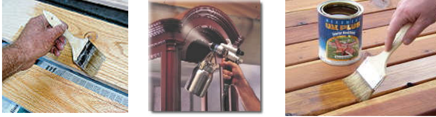
Resim 2.34: Fırça ve tabanca ile vernik uygulamaları
