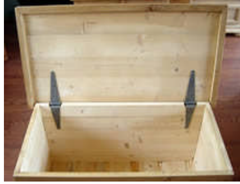
Resim 2.23: Çeyiz sandığının içinin ve menteşelerinin görünümü
