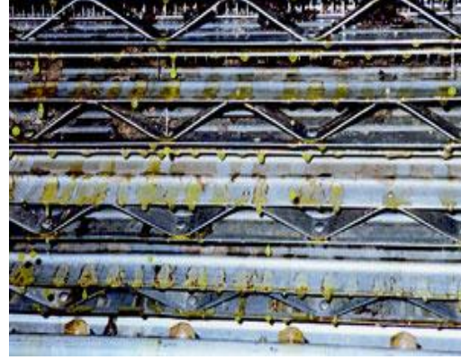
Resim 2.20: Plakaların yağ ile kaplanması
