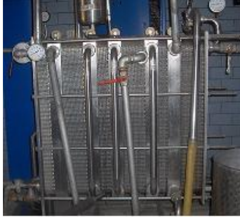
Resim 1.16: Plakalı ısı deęiřtirici
