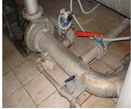
Resim 2. 4: Boyarmadde kimyasal madde ilave tankı ve ayar vanası
