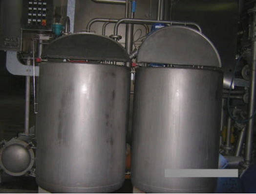
Resim 1.7:HT boyama mak. ilave tankı
