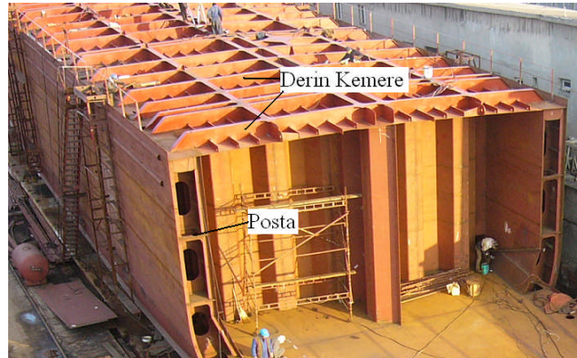
Resim 1.1: Yapım aşamasındaki bir geminin yapı elemanları
