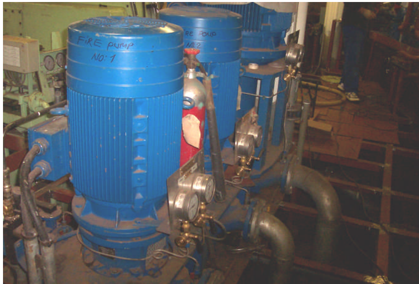
Resim 2.1: Normal yangin pompası
