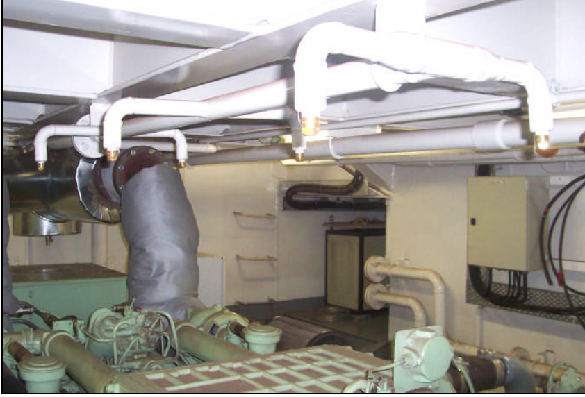
Resim 2.3: Makine dairesi yangın bağlantısı
