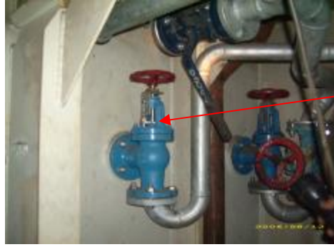
Resim 2.1: Makine dairesi atık su pompa devresi deniz boşaltma bağlantısı
