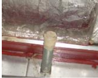
Resim 2.7: Çamaşır, bulaşık makinesi ve eviye atık su boru bağlantısı
