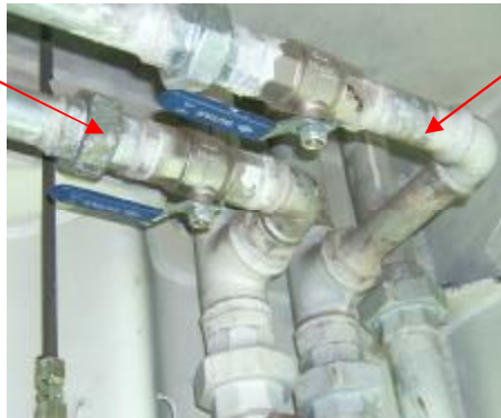
Resim 1.19: Temiz su branşman kolon bağlantısı
