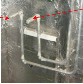
Resim 1.23: Mutfak eviye bağlantısı
