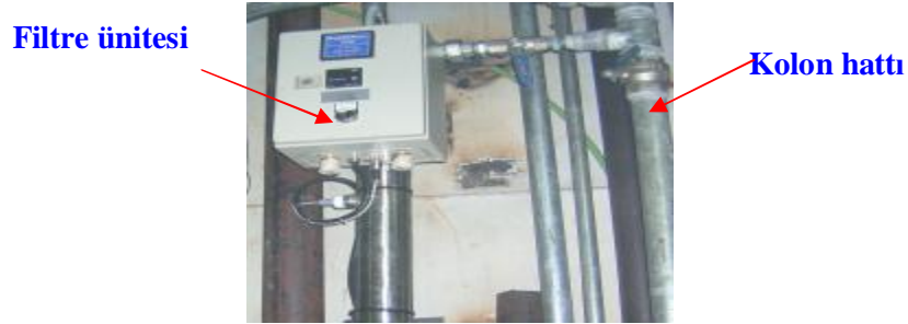
Resim 1.16: Filtre ünitesi
