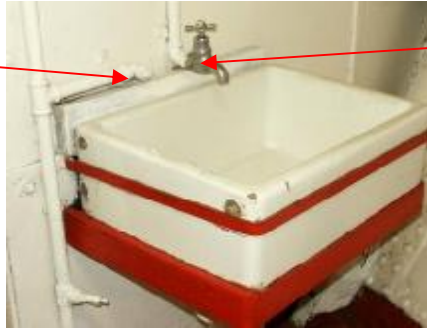
Resim 1.21: WC lavabo bağlantısı
