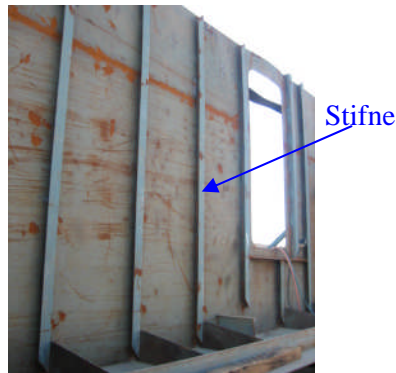
Resim 3.3: Köşebentten kesilmiş stifner
