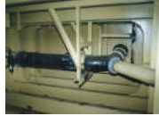
Resim 1.1: Balast tankı grp boru uygulaması
