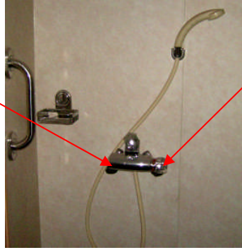
Resim 2.3: Banyo duş bağlantısı
