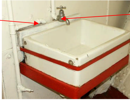
Resim 2.2: WC lavabo bağlantısı
