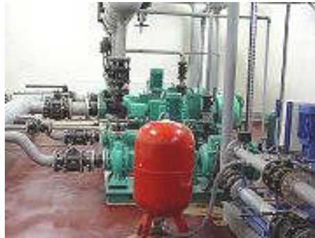
Resim 1.2: Hidrofor montaj
