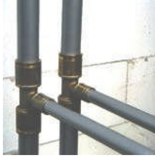
Resim 2.1: Boru tesisatı montajı
