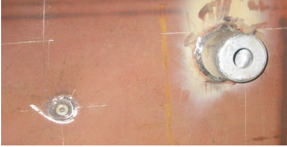
Resim 2.12: Ambar kapaklarının hava tahliye boruları
