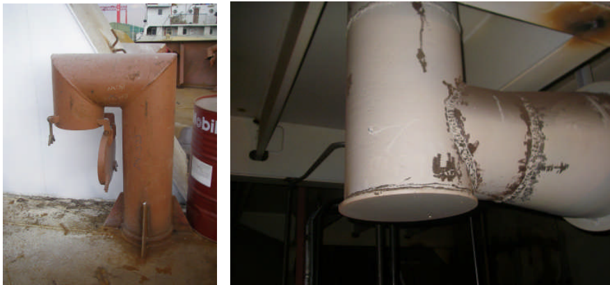
Resim 1.2: Manika havalandırma bağlantı kanalı
