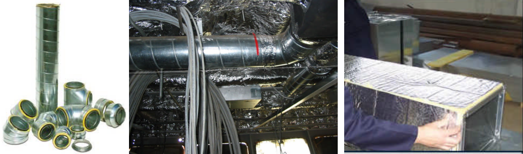
Resim 1.8: Havalandırma kanalları ve izolasyonu
