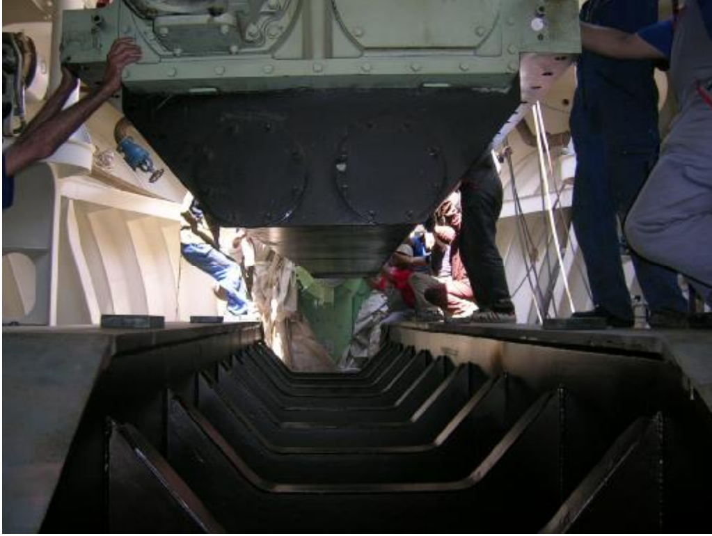
Resim 1.1: Ana makinenin faundeşına yerleştirilmesi
