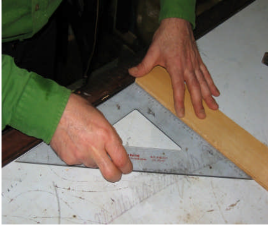
Resim 2.7: Çaktığımız çıtalarmın gönye ile dik açı oluşturup oluşturmadığı kontrol edilir ve sabitlenir.
