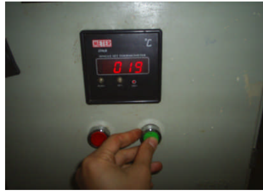
Resim 2.5:Otomatik kumanda panosu ve ayarlar
