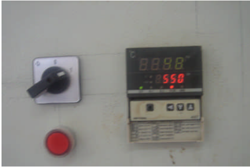
Resim 2.6: Kumanda panoları ve ısı ayarları panosu
