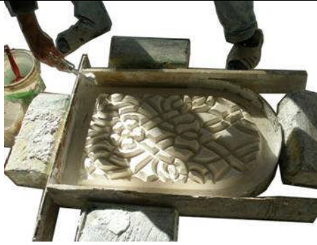
Resim 1.19: Kalıp kenarlarının kapatılması
