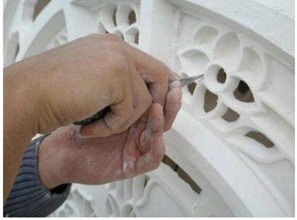
Resim 3.5: Kayıtların alçı bıçağı yardımıyla, açılı olarak temizlenmesi
