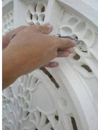
Resim 3.4: Kayıtların açılı temizlenmesi
