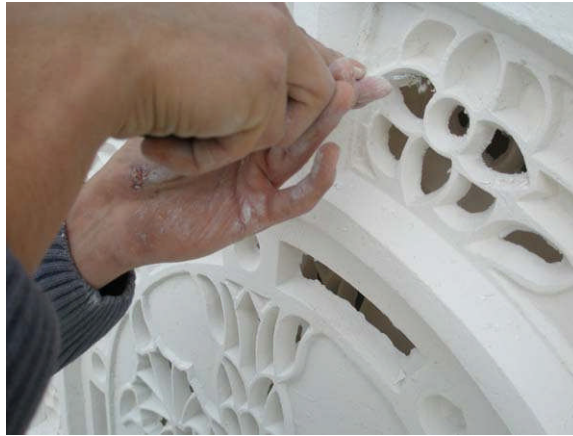
Resim 3.7: Kayıtların alçı bıçağı yardımıyla, açılı olarak temizlenmesi
