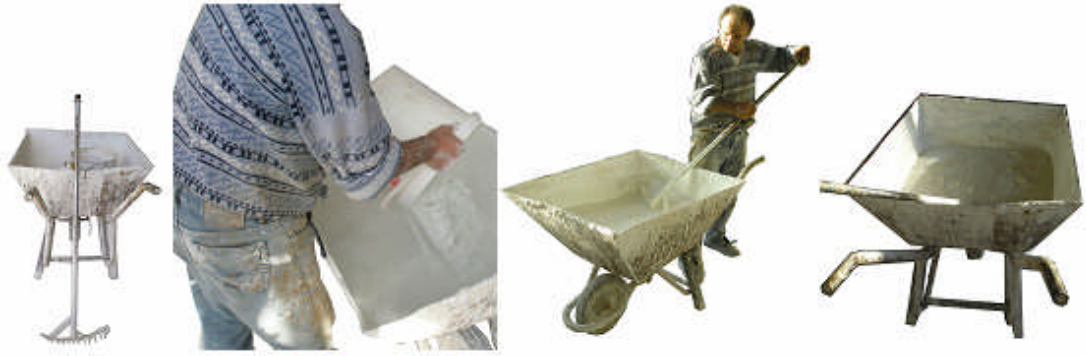
Resim 1.1: Metal kovada alçı hazırlama aşamaları
