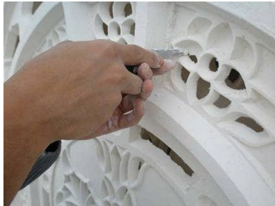
Resim 1.29: Alçı kayıtlar eğimli olarak kesilir
