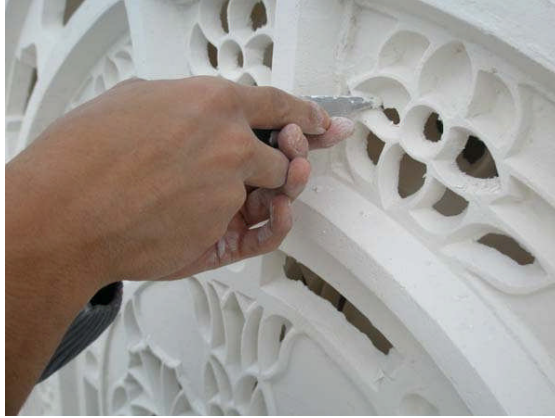
Resim.3.6: Kayıtların alçı bıçağı yardımıyla, açılı olarak temizlenmesi
