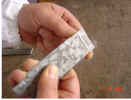
Resim 47: Çatı telinin kalıba sarılması
