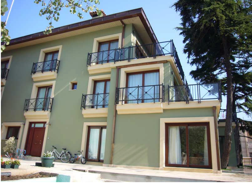
Resim 1.6: Güzel bir kâgir yapı
