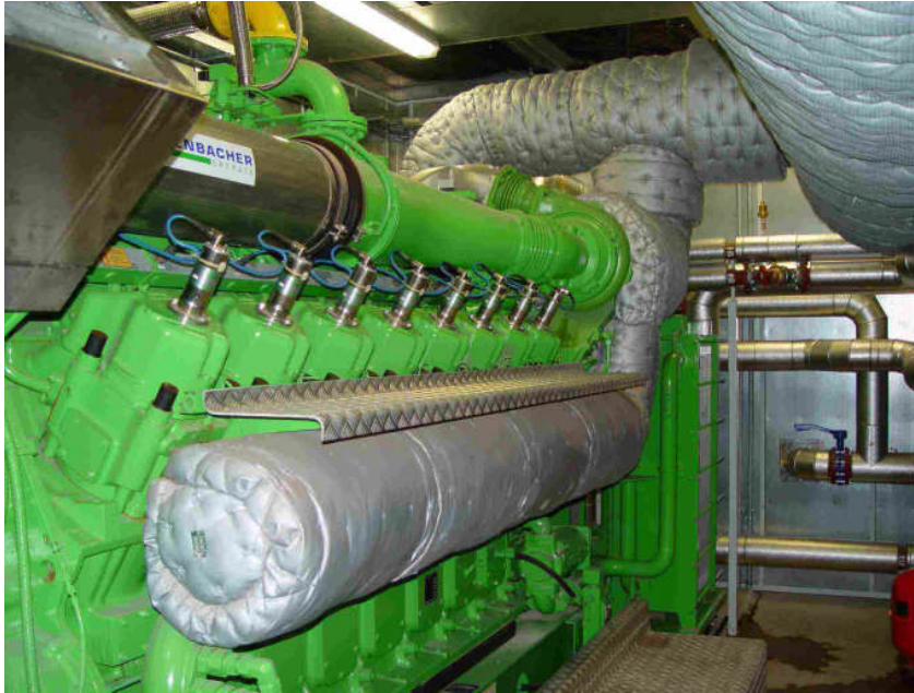
Resim 1.5: Egzoz manifoldu ve borularının yalıtılması
