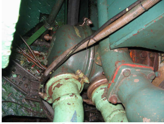
Şekil 2.15: Deniz suyu pompası
