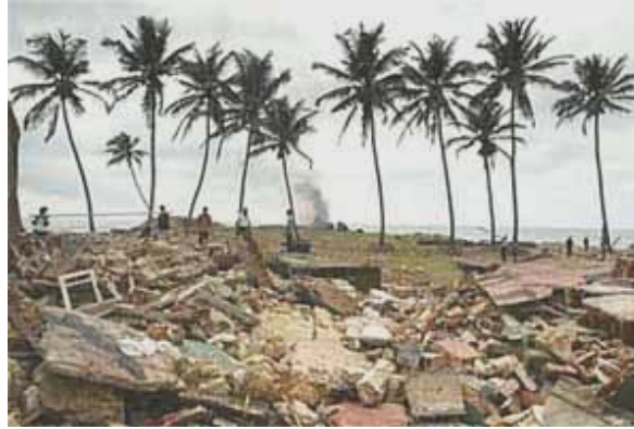
Resim 6: Tsunami'nin kıyıda yarattığı hasar
