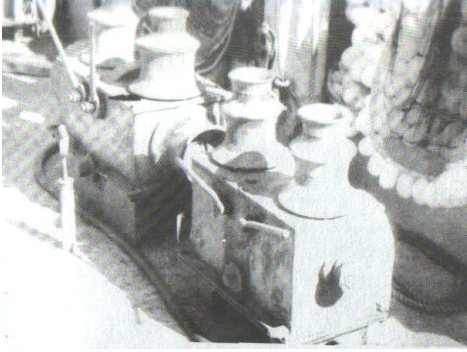
Resim 2.10: Ana makineye bağlı olarak çalışan ırgatlar ve üstündeki dikey fenerlikler.
