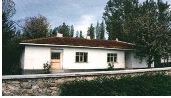
Şekil 23: Sağlık evi binası
