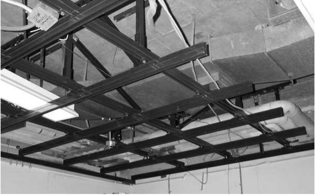
Resim 1.17: Bir cihazın tavan askı sistemi
