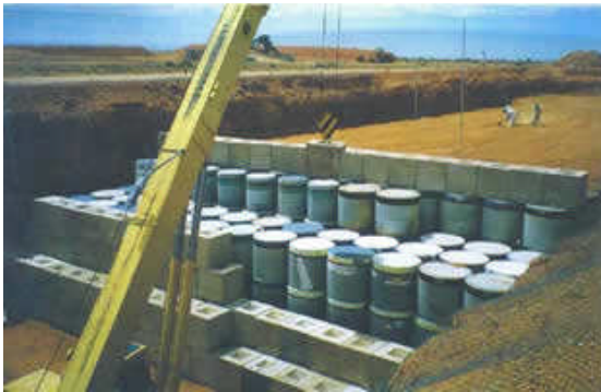
Resim 4.1: Yüzeysel depolama tesisi
