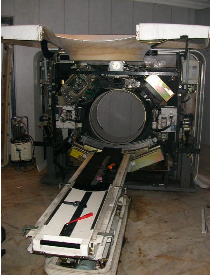
Resim 1.1: Manyetik rezonans cihazı bakım-onarım için sökülmüş hâli
