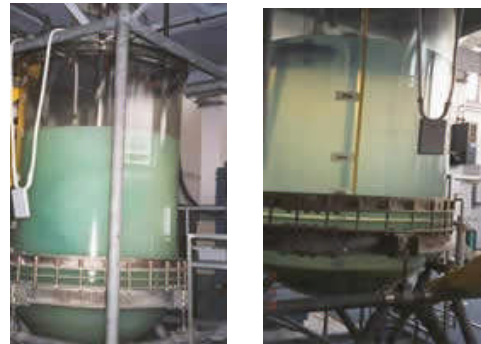
Resim 4.2: ÇNAEM atık tesisi çöktürme tankı
