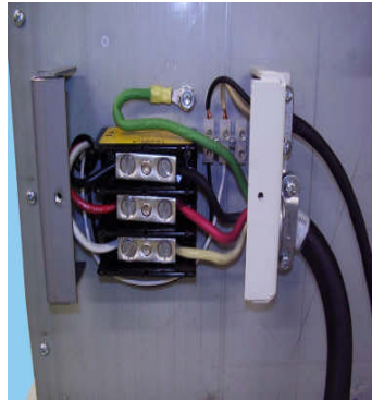
Resim 8.14: Güç kablosu bağlantı noktası
