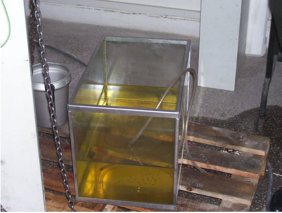
Resim 2.8: Sökülmüş YV trafo yağının boşaltılmış hâli
