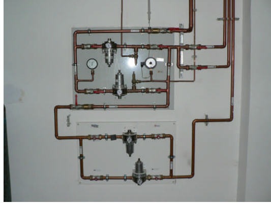
Resim 2.1: Hava tesisat örneği
