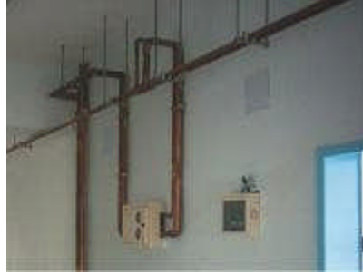
Resim 2.13: Takılmış halde gaz alarm panelleri
