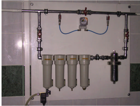
Resim 2.2: Kompresör filtre tesisatı
