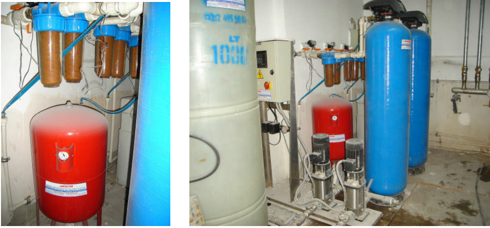
Fotoğraf 3.1:Diş üniti ana su filtreleri
