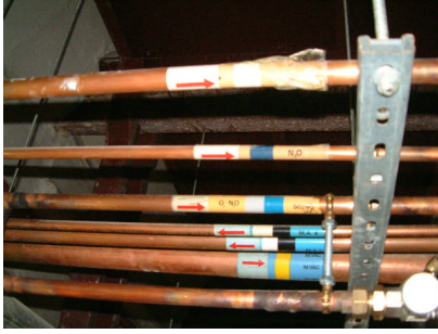
Fotoğraf 4.8.2: Duvar içi gaz tesisatı
