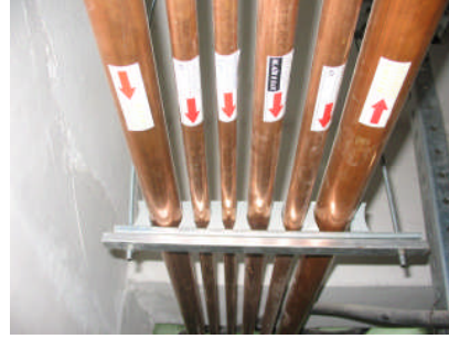
Fotoğraf 4.8.3: Duvar içi gaz tesisatı
