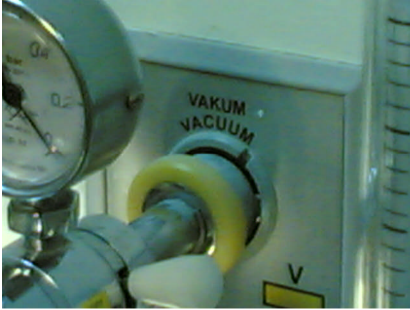
Resim 1.10: Merkezi aspiratör cihazı vakum giriş jakları ve gösterge kadranı
