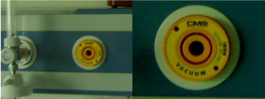
Resim 1.21: Merkezi aspiratör hasta başı vakum jakı ve tüpleri
