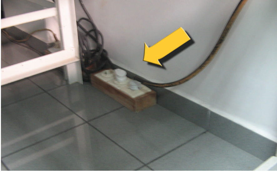
Resim 1.10: Kuru hava sterilizatörünün hatalı düzenlenmiş priz tertibatı
