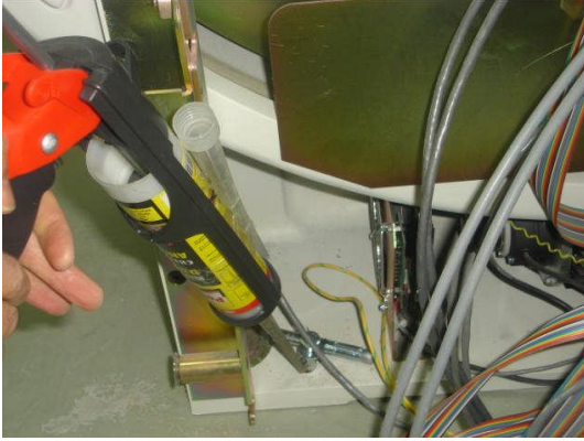
Resim 2.64: Kimyasal dübel sıkılması-1
