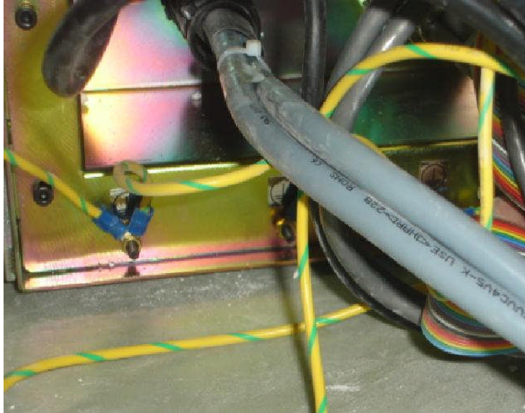
Resim 2.40: Yapılan toprak bağlantıları
