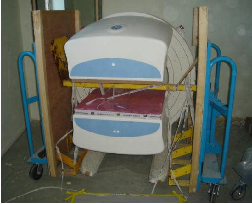
Resim 2.12: Gantry'nin yerleşim planı üzerine dolly ile taşınması
