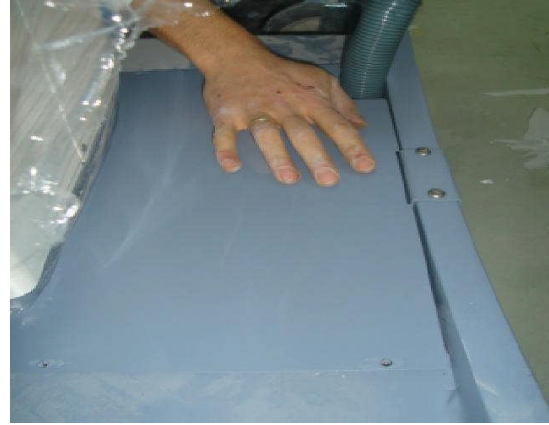
Resim 4.8: Metal parçanın takılması
