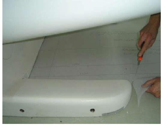
Resim 2.26:Yerleşim planının yerden sökülmesi-1 Resim 2.27:Yerleşim planı sökülmesi-2 Bundan sonraki aşamada IPS ( akıllı güç kaynağı ) ve kapağı ambalajından çıkartılır.
