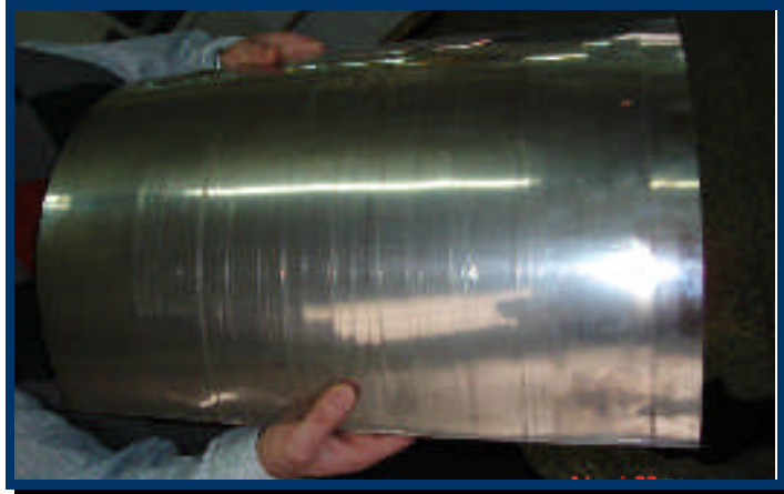
Resim 2.9: Piliyaj ve perforaj baskısı yapan kazana çelik kılıf giydirme
