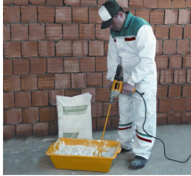
Resim 2.8: Mikserle karıştırılması
