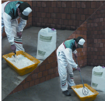
Resim 2.9: Harcın karıştırılması
