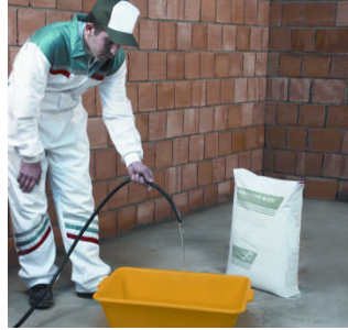
Resim 2.5: Harç için su alınması
