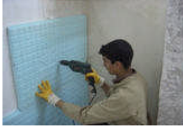
Resim-3.12: Plastik izolasyon dübel tespiti
