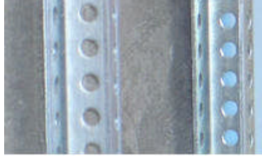
Resim 3.8: Mantolama etek profili montajı
