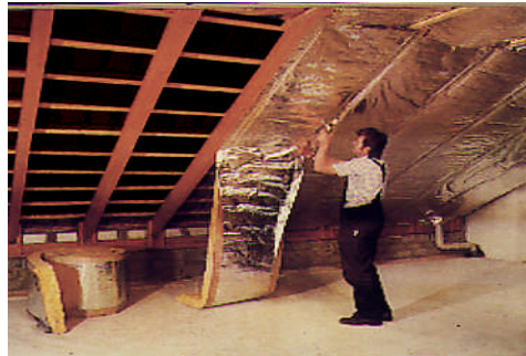
Resim 1.4: Yangına karşı yapılan çatı yalıtımı
