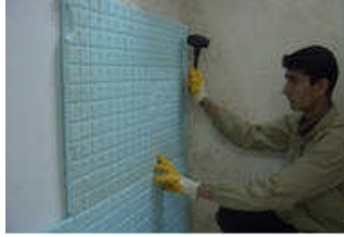
Resim 3.11: Duvara yapıştırma
