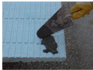
Resim 3.10: Polistren arkasının harçlanması
