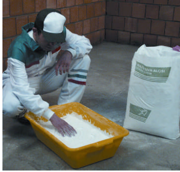
Resim 2.7: Malzemenin çökmesinin kontrolü
