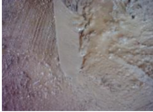
Resim 2.14: Harcın ve serpmenin yapıldığı yerin temizlenmesi
