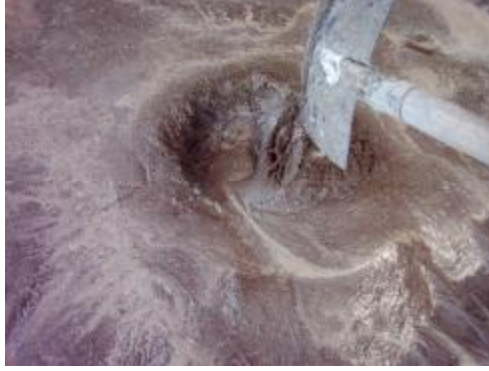
Resim 1.18: Kum ile kirecin karıştırılması
