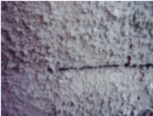
Resim 2.12: Sıva altı serpme yapılmış yüzey
