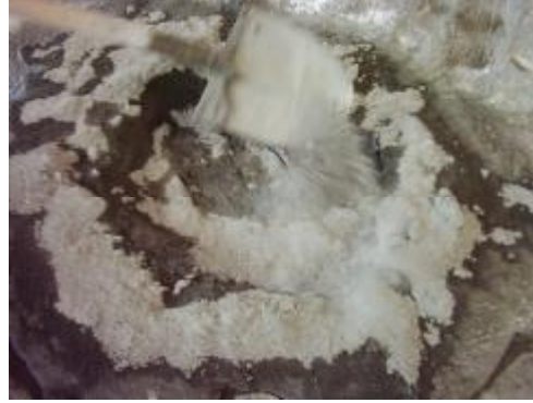
Resim 1.22: Çimentonun kireç harcına serpilmesi
