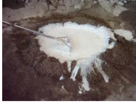
Resim 1.16: Kireç ile suyun gelberi ile karıştırılması
