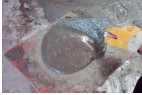
Resim 2.8: Harcın sıvacı küreğine alınması
