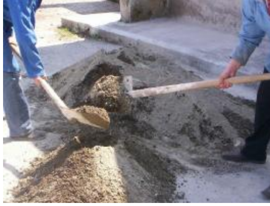
Resim 2.1: Kum ve çimentonun kuru olarak karıştırılması
