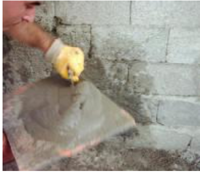
Resim 2.9: Harcın yüzeye çarpılarak uygulanması
