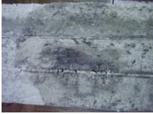
Resim 2.7: Yüzeyin ıslatılması
