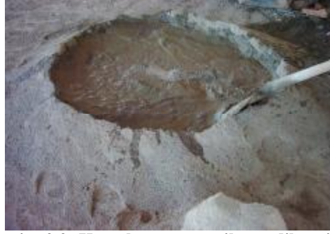
Resim 2.2: Kuru karışıma su ilave edilmesi
