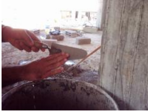
Resim 2.16: Araların temizlenmesi
