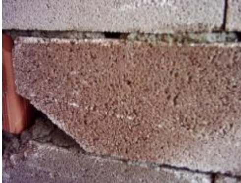
Resim 2.6: Yüzeyin doldurularak düzeltilmesi
