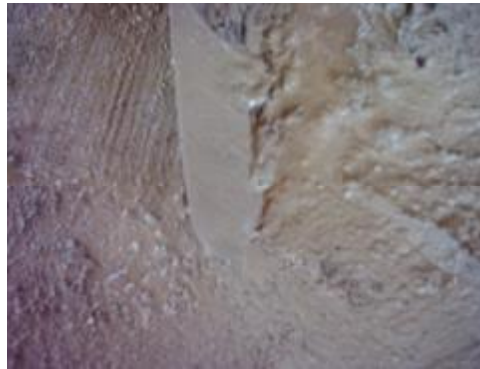
Resim 1.26: Harç yapılan yerin temizlenmesi
