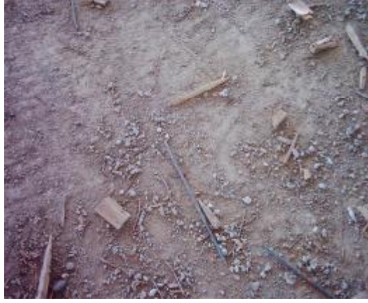
Resim 1.5: Harç yapılacak yerin temizlenmemiş hali
