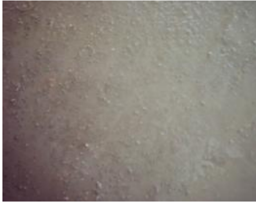
Resim1.6: Harç yapılacak yerin temizlenmiş hali
