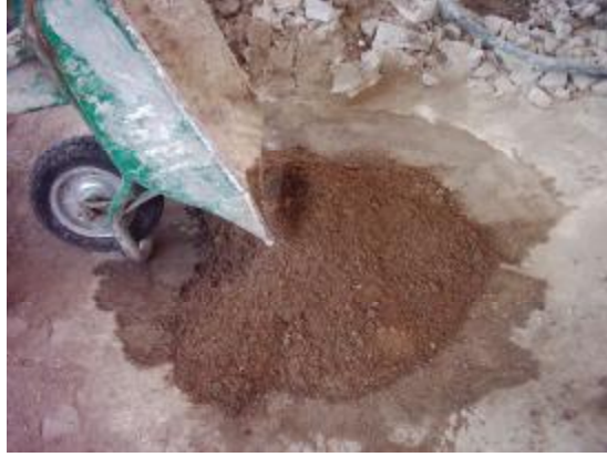
Resim 1.10: Kumun el arabası ile taşınması
