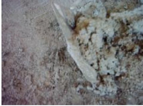
Resim 2.13: Dökülen harcın toplanması
