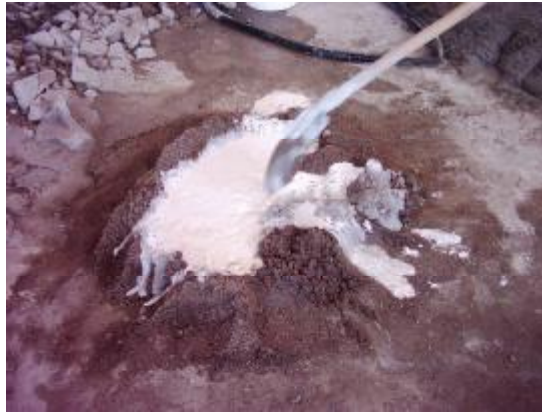
Resim 1.17: Kum ile kirecin karıştırılması
