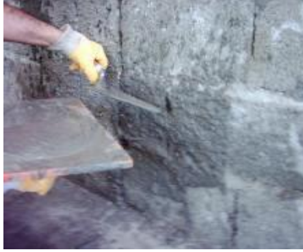
Resim 2.10: Harcın yüzeye çarpılarak uygulanması
