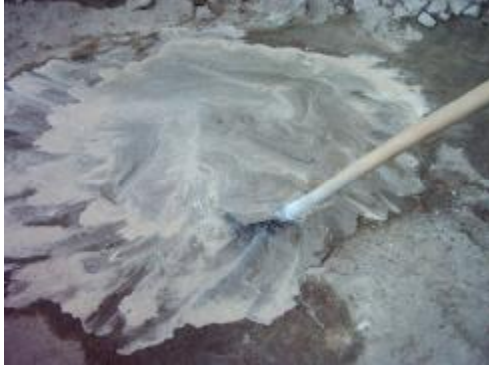
Resim 1.19: Kireç harcının dinlendirilmesi
