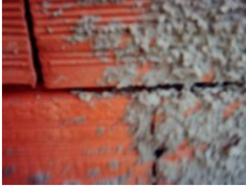
Resim 2.11: Harcın yüzeye çarpılarak uygulanması
