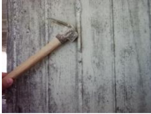
Resim 2.5: Yüzeyin kırılarak düzeltilmesi
