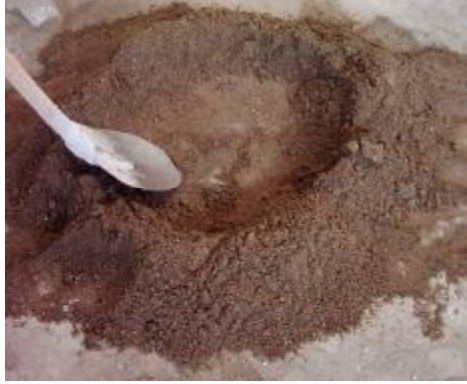
Resim 1.12: Kumun ortasını açılması
