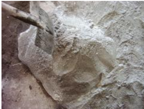
Resim 1.20: Kireç harcının alınması
