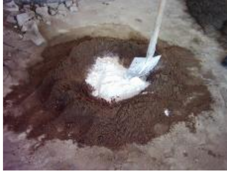
Resim 1.13: Çukura kirecin dökülmesi
