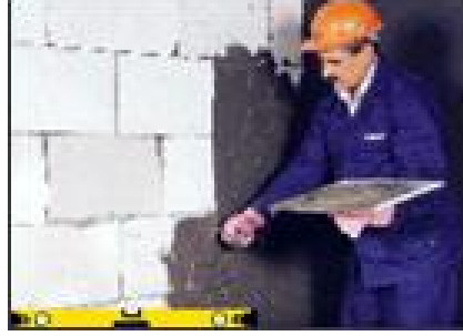
Resim 34: Harcın Yüzeye Uygulanması
