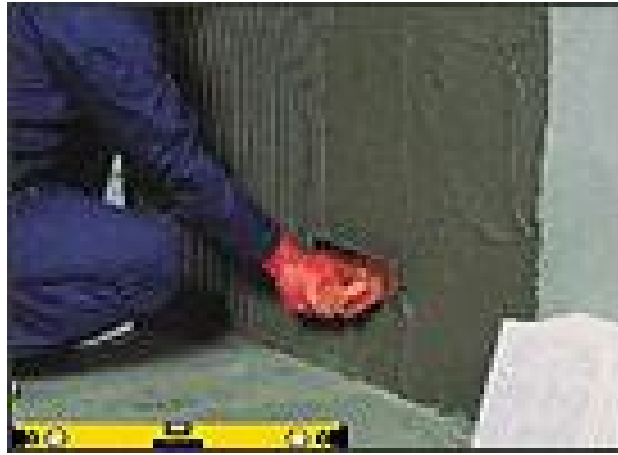
Resim 35: Harcın Yüzeye Uygulanması
