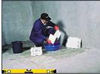
Resim 13: Seramiklerin Islatılması
