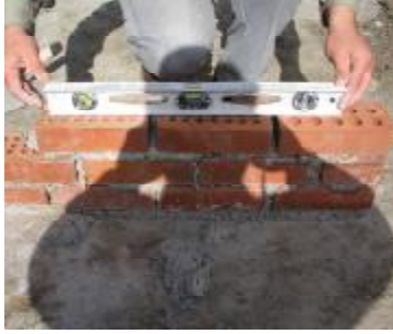
Resim 15 15. Tuğla sıralarının aynı olup olmadığını master ve su düzeci yardımıyla kontrol ediniz. (Resim.15)
