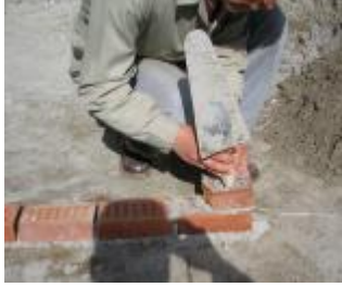
Resim 11 11. İkinci sıranın başına yarım tuğlayı ve diğer uçtaki tam tuğlayı, yarım tuğla kaydırarak yerleştiriniz. ( Resim.11)
