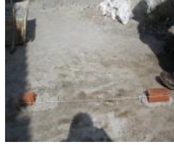
Resim 8 8. Köşe tam tuğlalarından, duvarın ön yüzüne göre ip çekiniz. (Resim.8)
