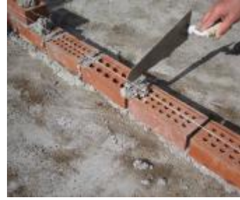
Resim 10 10. Derzleri sıvamadan, doldurunuz. (Resim.10)
