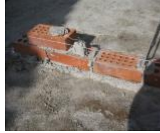
Resim 11 12. Köşe tuğlalarının ipini çekiniz. (Resim.11)
