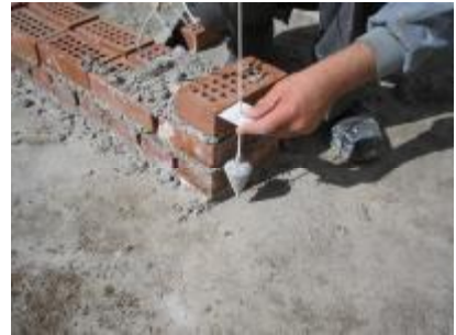
Resim 8 8. Duvar köşelerini üçüncü sıradan itibaren çekül ile kontrol ediniz. (Resim.8)
