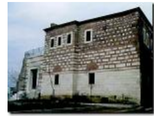
İnce yonu taş duvar
