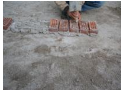
Resim 2 2. Köşe tuğlalarından, duvarın ön yüzüne göre ip çekiniz. (Resim.2)
