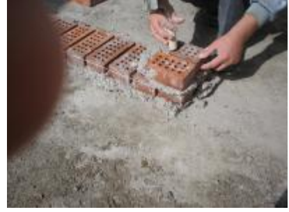
Resim 4 4. İkinci sıranın baş tarafına üç çeyrek (3/4) tuğlalardan iki adet yan yana düz olarak yerleştiriniz. (Resim.4)
