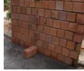
Blok tuğla duvar
