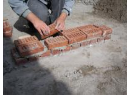
Resim 6 6. Köşe tuğlalarından ipi çekiniz. (Resim.6)
