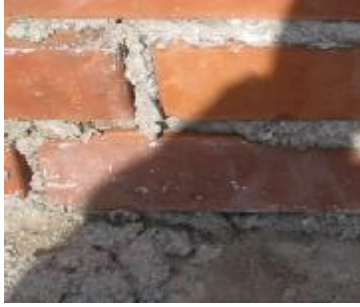
Resim 13 13. Ara tuğlaları ipe uyarak harçlı olarak yerleştiriniz. (Resim.13)
