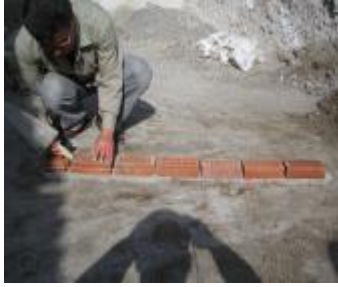
Resim 9 9. Ara bölmeyi harçlı ve ipe göre örünüz.(Resim.9)
