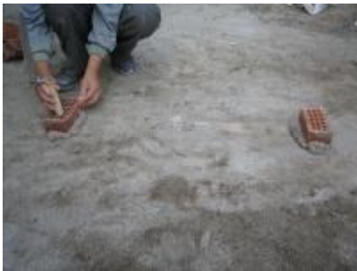
Resim 1 1. Birinci sıranın köşe tuğlalarını kilit olarak yerleştiriniz. ( Resim.1)
