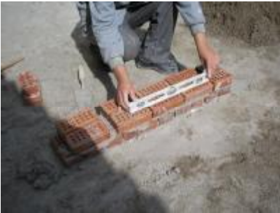
Resim 7 7. Ara tuğlaları ipe uyarak harçlı olarak yerleştiriniz. (Resim.7)
