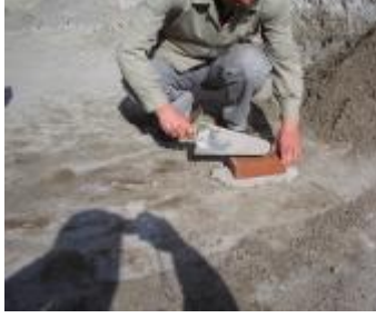
Resim 7 7. Birinci sıra köşe tam tuğlalarını yerleştiriniz. ( Resim.7)
