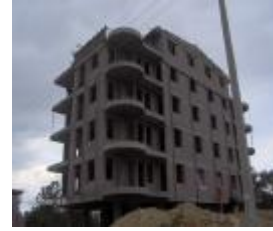
Bims blok uygulaması
