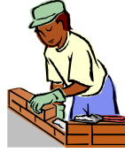
Resim 13 13. Ara tuğlaları ipe uyarak harçlı olarak yerleştiriniz. (Resim.13)
