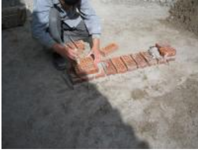
Resim 5 5. İkinci sıranın sonuna, düşey derzler birbirinden çeyrek (1/4) tuğla boyu kayacak şekilde, iki adet tam tuğlayı, yan yana düz örgü şeklinde koyunuz. (Resim.5)
