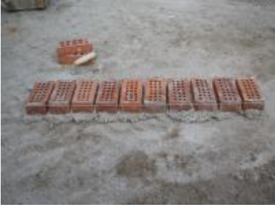
Resim 3 3. Ara tuğlaları, kilidine ve ipe uygun yerleştiriniz. (Resim.3)
