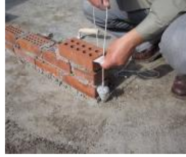
Resim 14 14. Duvar köşelerini üçüncü sıradan itibaren çekül ile kontrol ediniz. (Resim.14)
