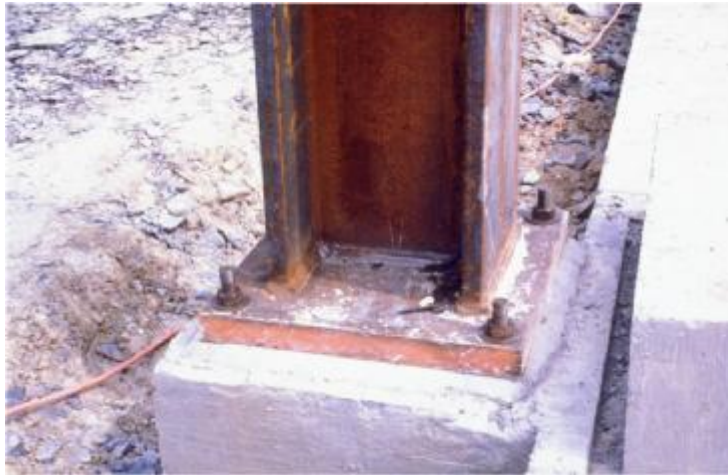
Şekil 3.1: Ankastre ayak ve BA temel birlikte görünüşü (nervürlü levha kullanılmamıştır)
