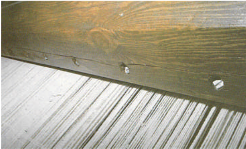
Resim 2.5: Çubuk demirinin üst merdaneye yerleştirilip sabitleştirilmesi
