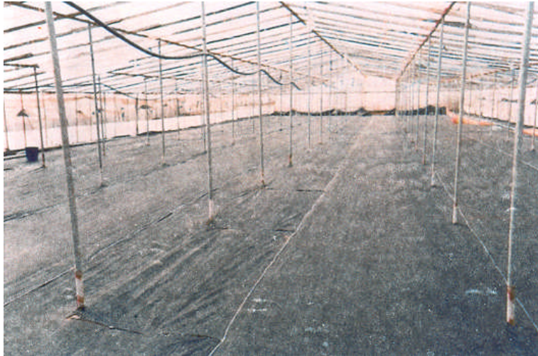
Fotoğraf 1.4: Taban örtüsünün serilmesi
