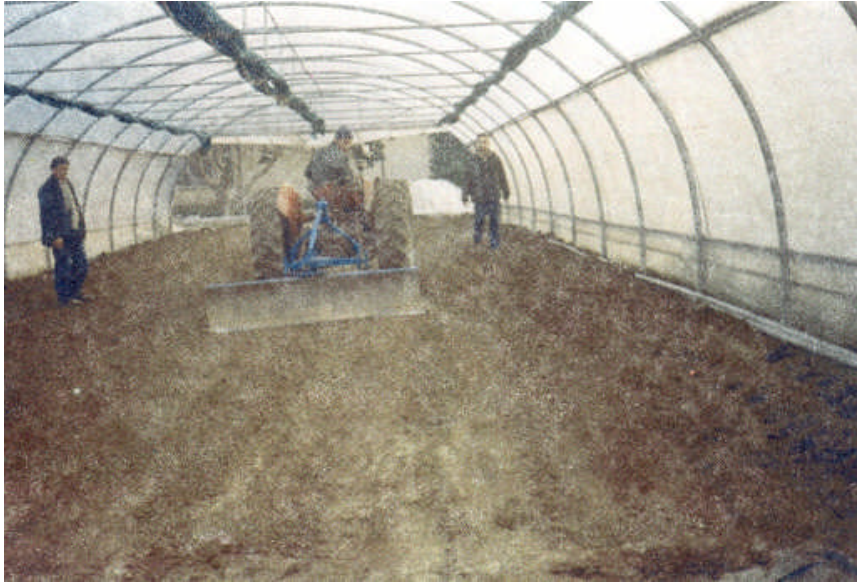
Fotoğraf 1.2: Seraya eğimin verilmesi
