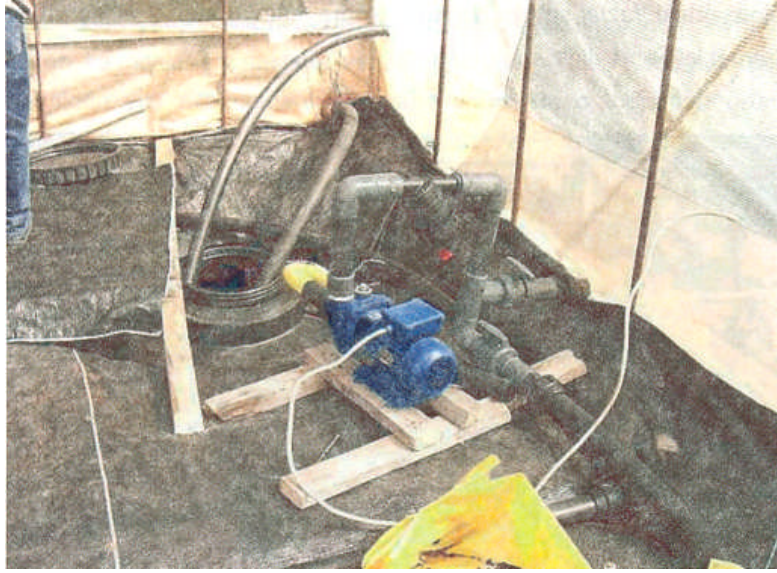
Fotoğraf 1.3: Sulama ve gübreleme tanklarının yerleştirilmesi
